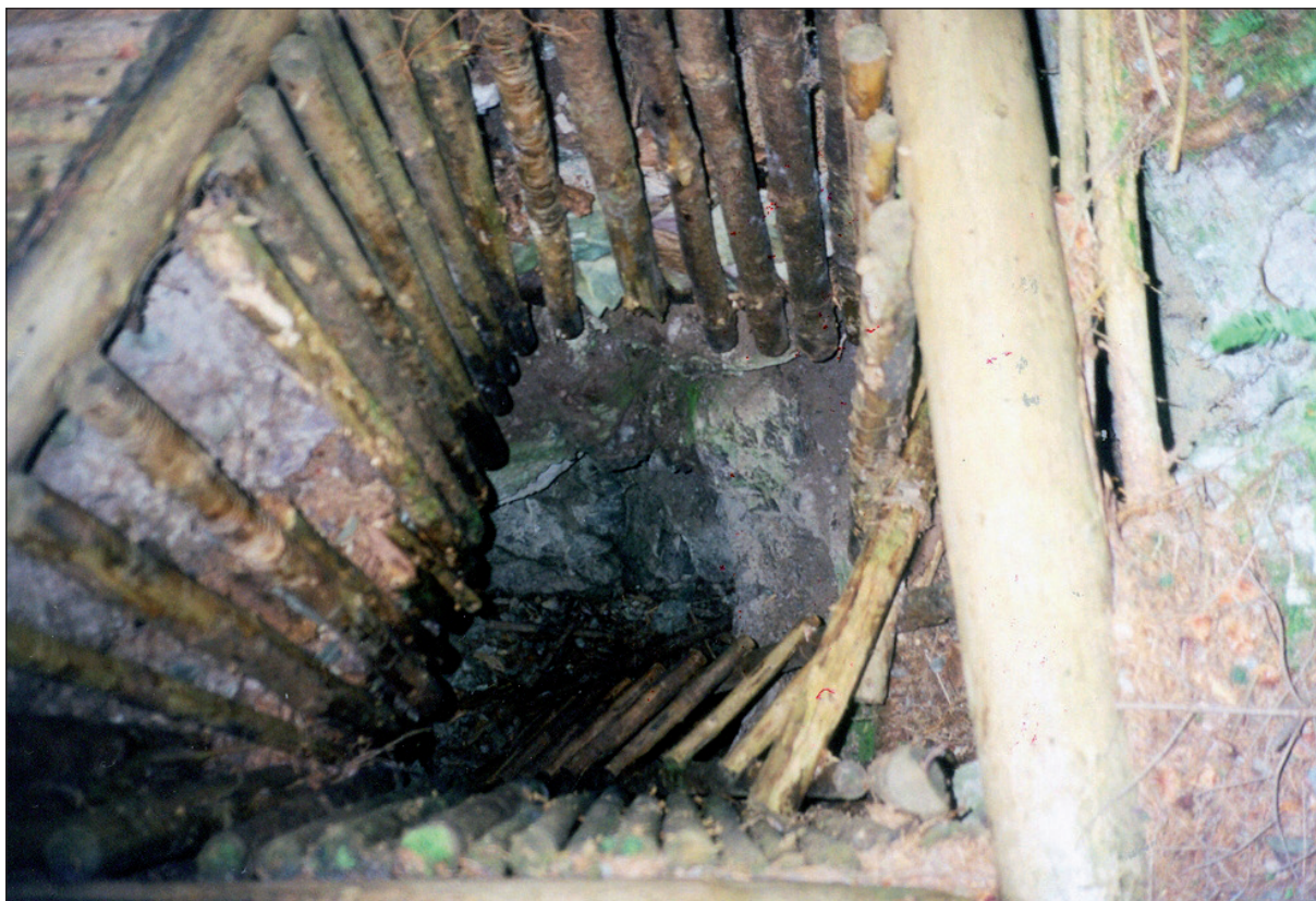
Obr. 10: Hranovnica – pohľad do šachtice H-1 s výdrevou
