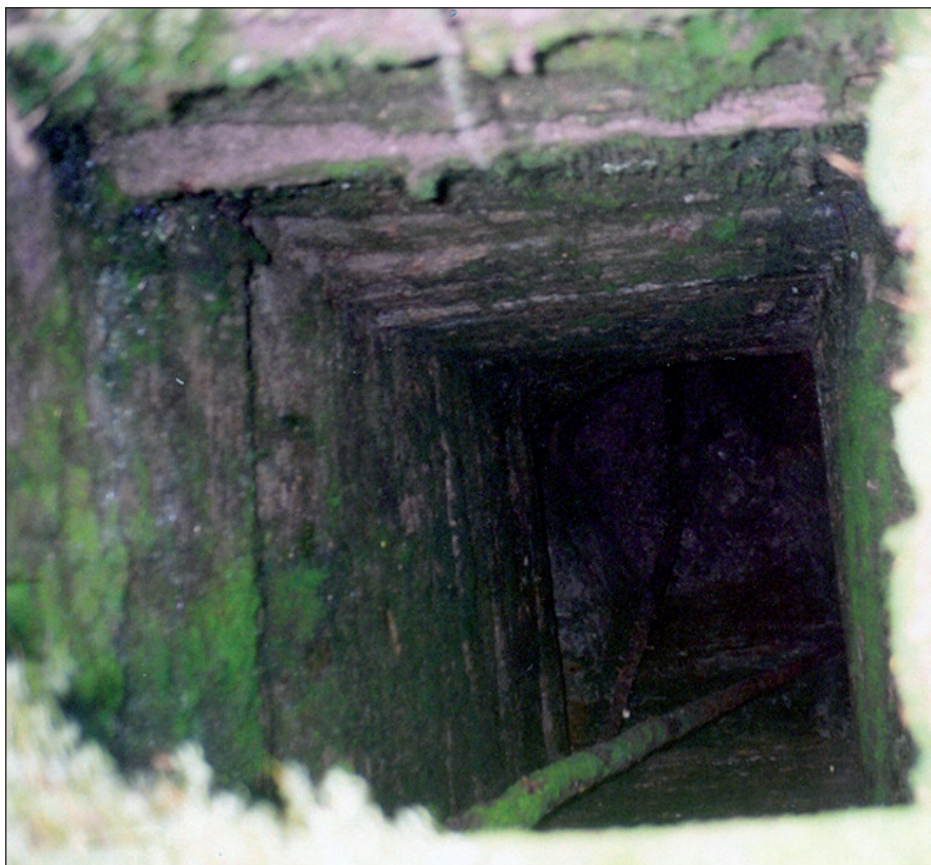
Obr. 14: Vernár – šachtica s výdrevou v polohe Kolvač
