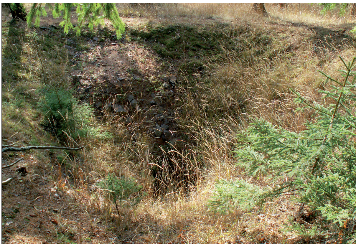
Obr. 19: Kravany – prevalený strop štólne
