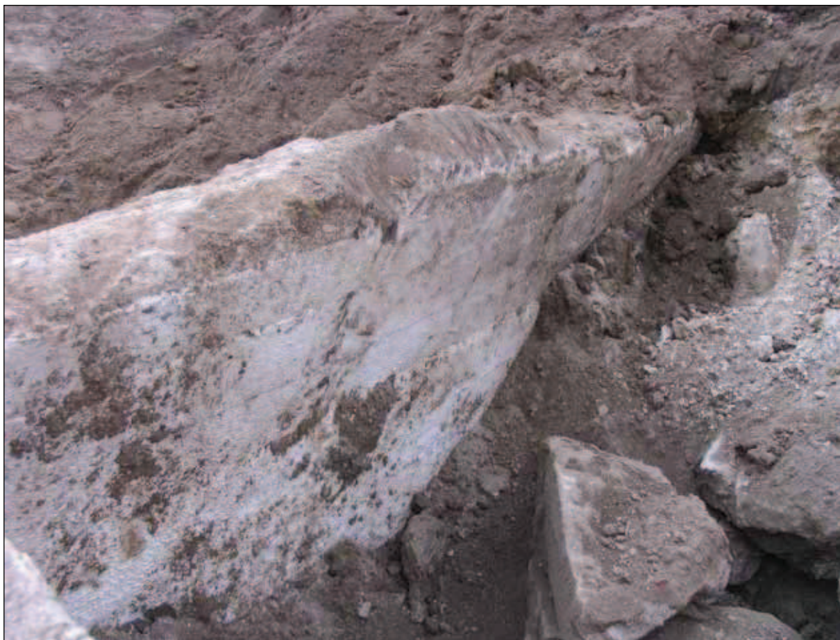
Obr. 5. Brno, Dům umění. Detail otisků bednění litého betonu. (archiv Archaia Brno foto i. č. 02270-2008)
