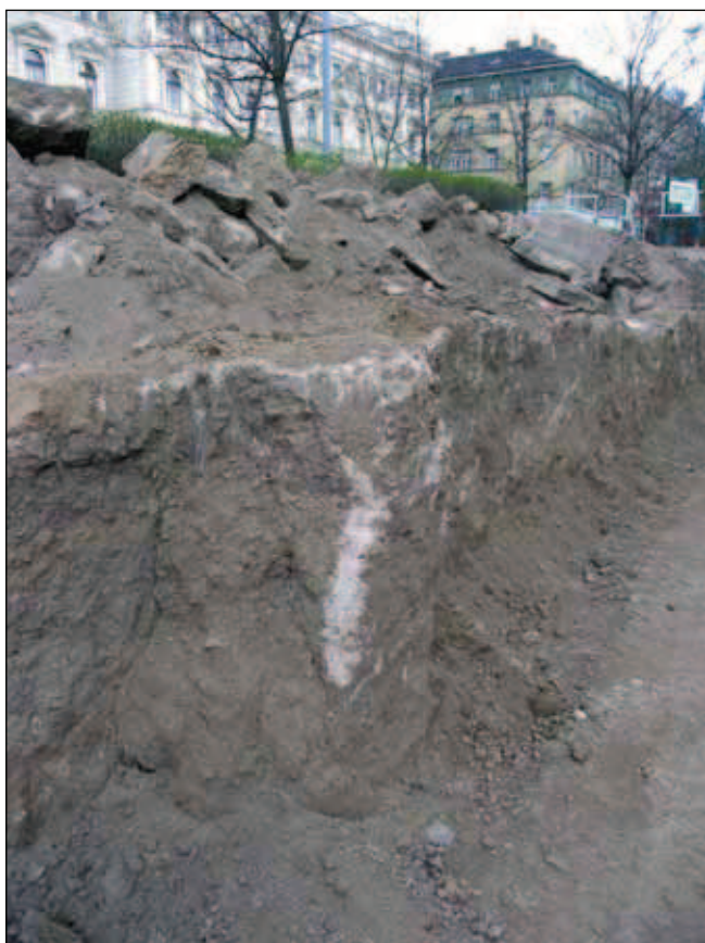
Obr. 5. Brno, Dům umění. Detail otisků bednění litého betonu. (archiv Archaia Brno foto i. č. 02270-2008)
