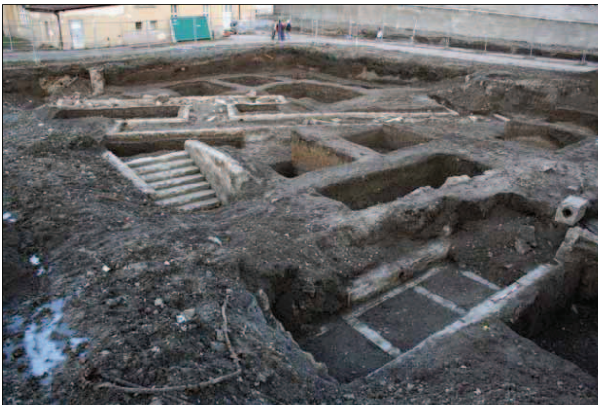
Obr. 2. Brno, Fakultní nemocnice u sv. Anny. Pohled od jihovýchodu na kryty s.s.j. 003 a 004. Je patrné vstupní schodiště do krytu s.s.j. 004. (archiv Archaia Brno foto i. č. 00797-2009)
