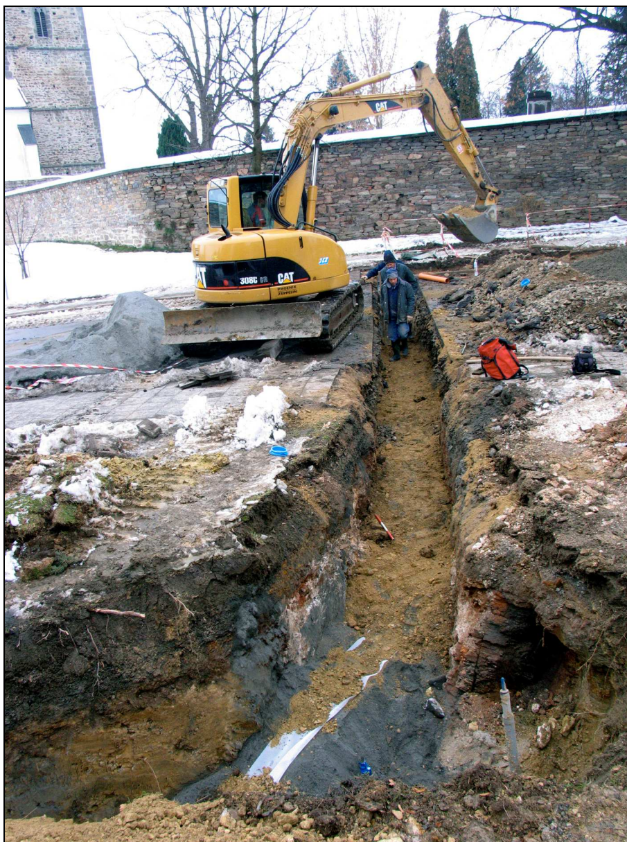
Obr. 3 Severní stěna pece nalezené ve výkopu vodovodního řadu ve vztahu ke kostelu sv. Jana Křtitele a jeho opevnění
