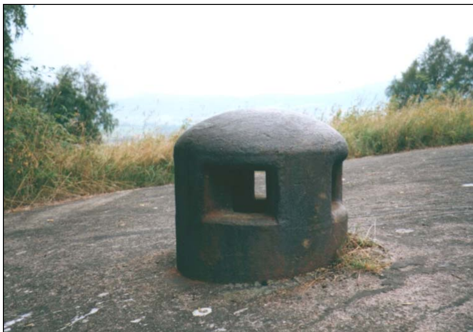
Obr. 2 Ventilační zvon tvrzové dělostřelecké věže K–Bg–S 12 „Na kótě“ u Králík. Foto M. Vlach
