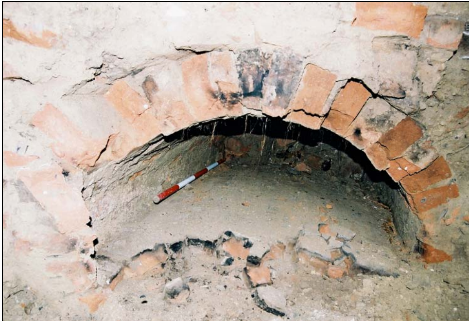
Obr. 4 Pohled ze sondy do topeniště pece.
