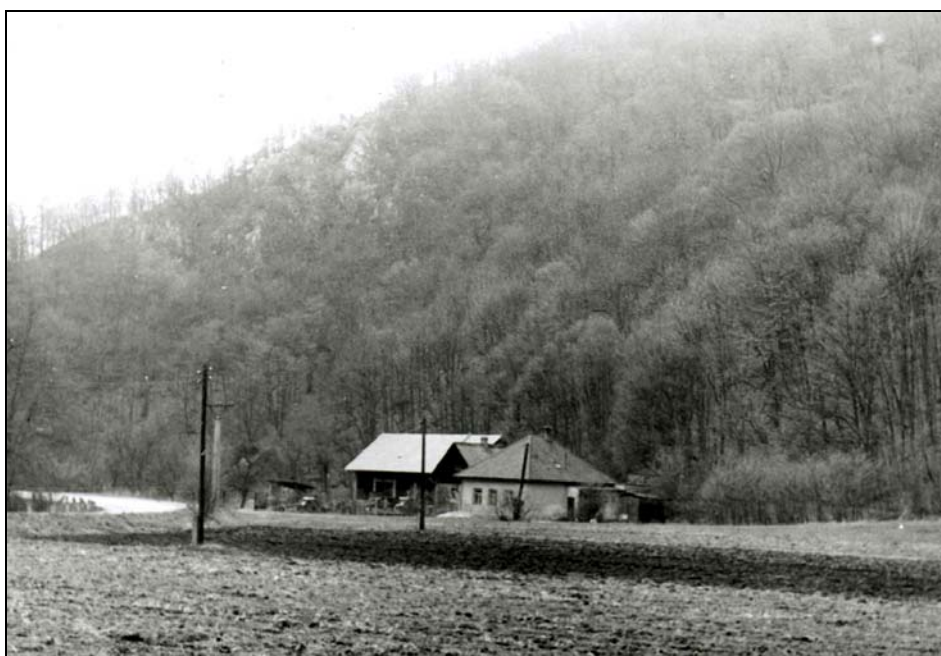
Obr. 2 Bývalý Baráčkův mlýn v dubnu v roce 1989 (foto K. S.)
