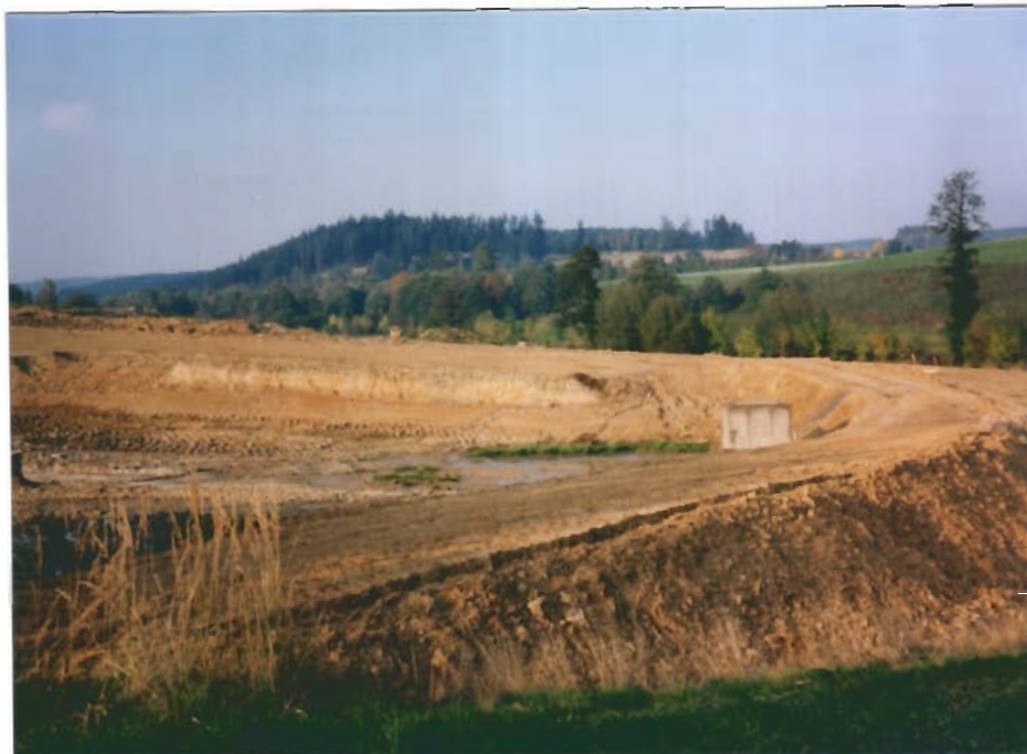
Obr. 2 Stavba hráze obnovovaného rybníka.
